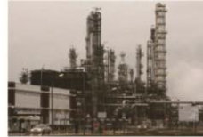
REFINERY Schwedt, Germany 2 x 740 t/h, 120 bar
