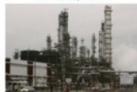
REFINERY Schwedt, Germany 2 x 740 t/h, 120 bar
